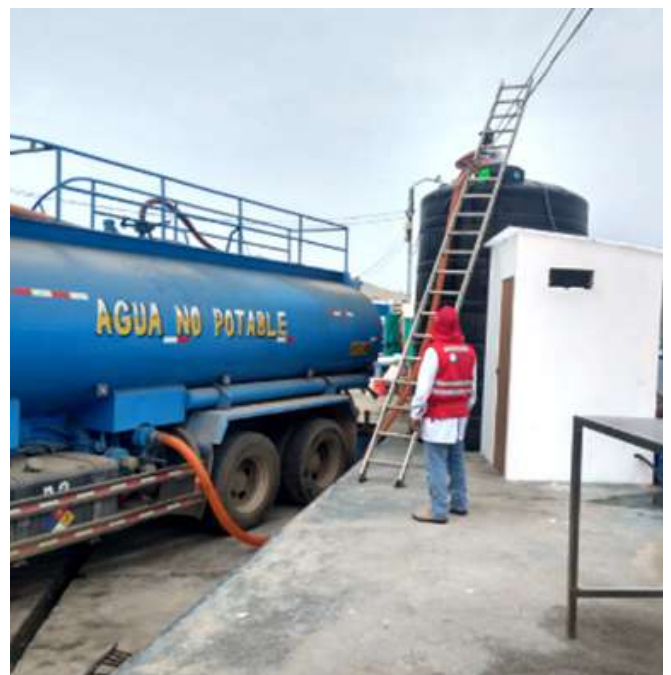
Código: RF/ODCAL/2022-04 Fecha: 11/02/2022 Lugar: MOLO MUELLE ANCÓN Descripción: Tanque (10000 litros) para el almacenamiento de agua de mar con 2 bombas para abastecer lados norte y sur.
