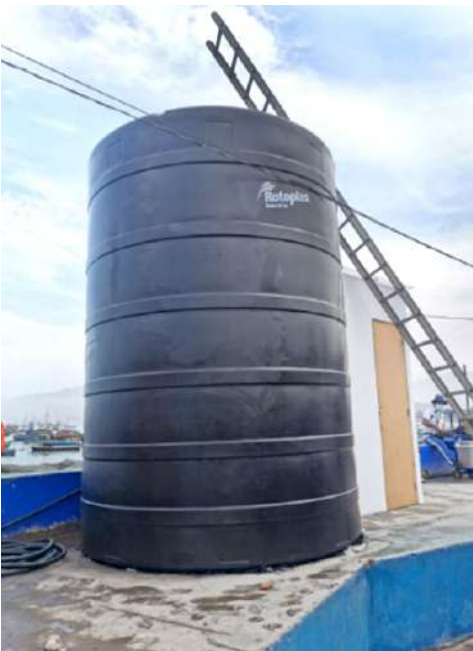
Código: RF/ODCAL/2022-04 Fecha: 14/02/2022 Lugar: MOLO MUELLE ANCÓN Descripción: Tanque de almacenamiento de agua de mar de Chorrillos.
