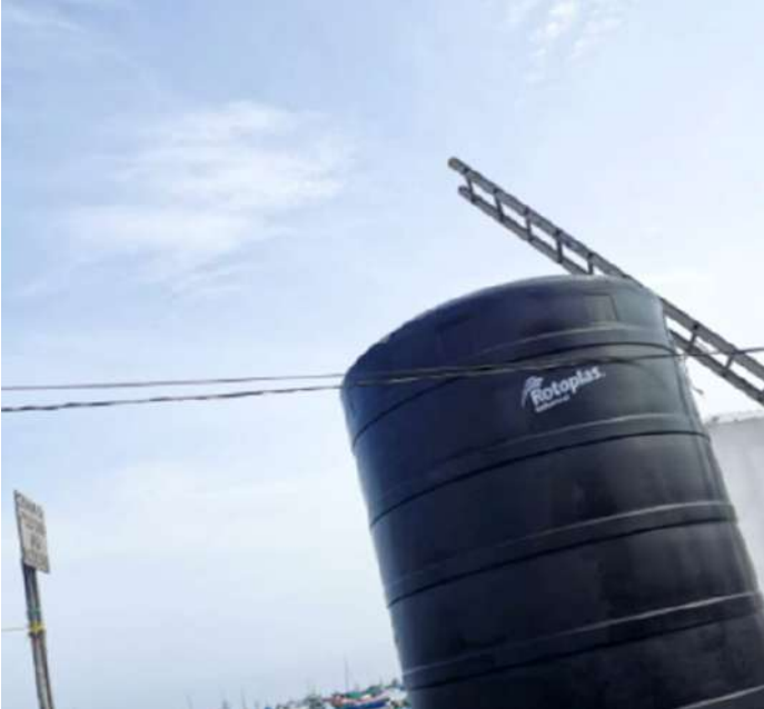
Código: RF/ODCAL/2022-03 Fecha: 17/02/2022 Lugar: MOLO MUELLE ANCÓN Descripción: Tanque de almacenamiento de agua de mar.
