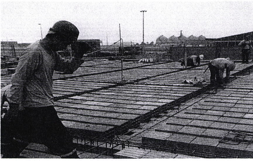
TECHO 2DO PISO BLOQUE PRINCIPAL EJES D - M
