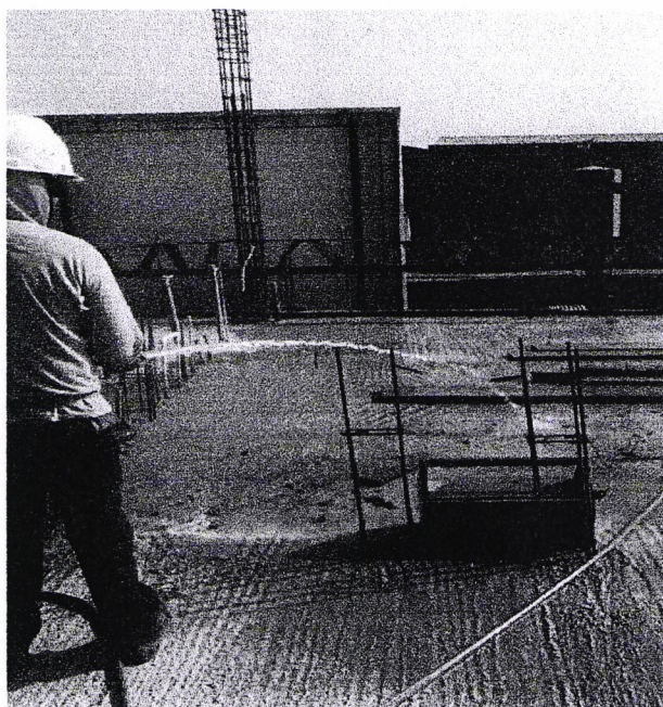
CURADO DE CONCRETO 1ER PISO BLOQUE PRINCIPAL
