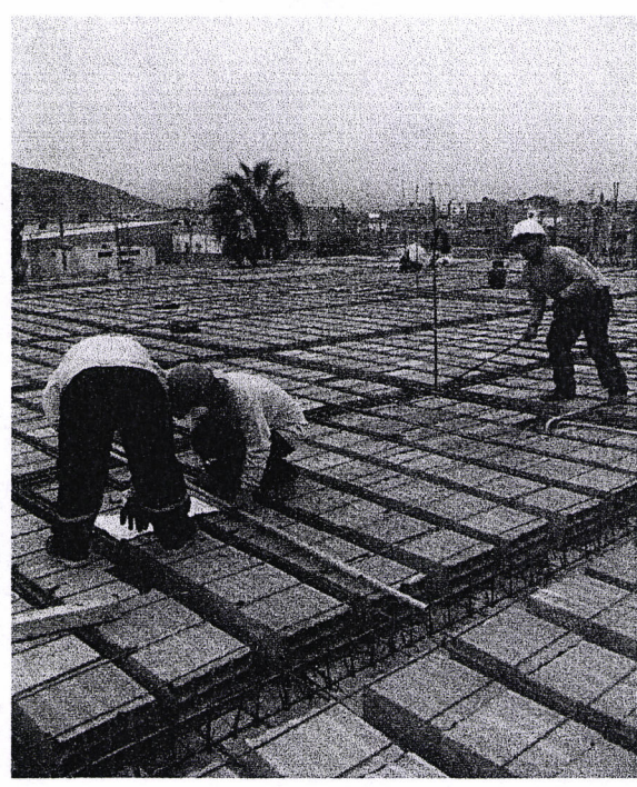
INSTALACIONES ELECTRICAS TECHO 2DO PISO BLOQUE PRINCIPAL EJES D - M
