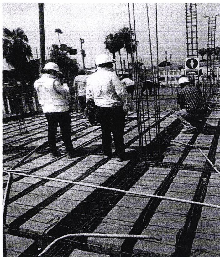
VACIADO CONCRETO TECHO 1ER PISO BLOQUE PRINCIPAL EJES A - C
