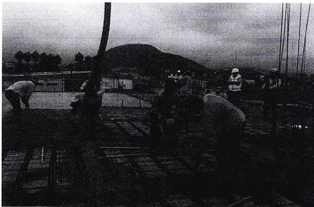
VACIADO DE CONCRETO TECHO 2DO PISO BLOQUE PRINCIPAL EJES A - C
