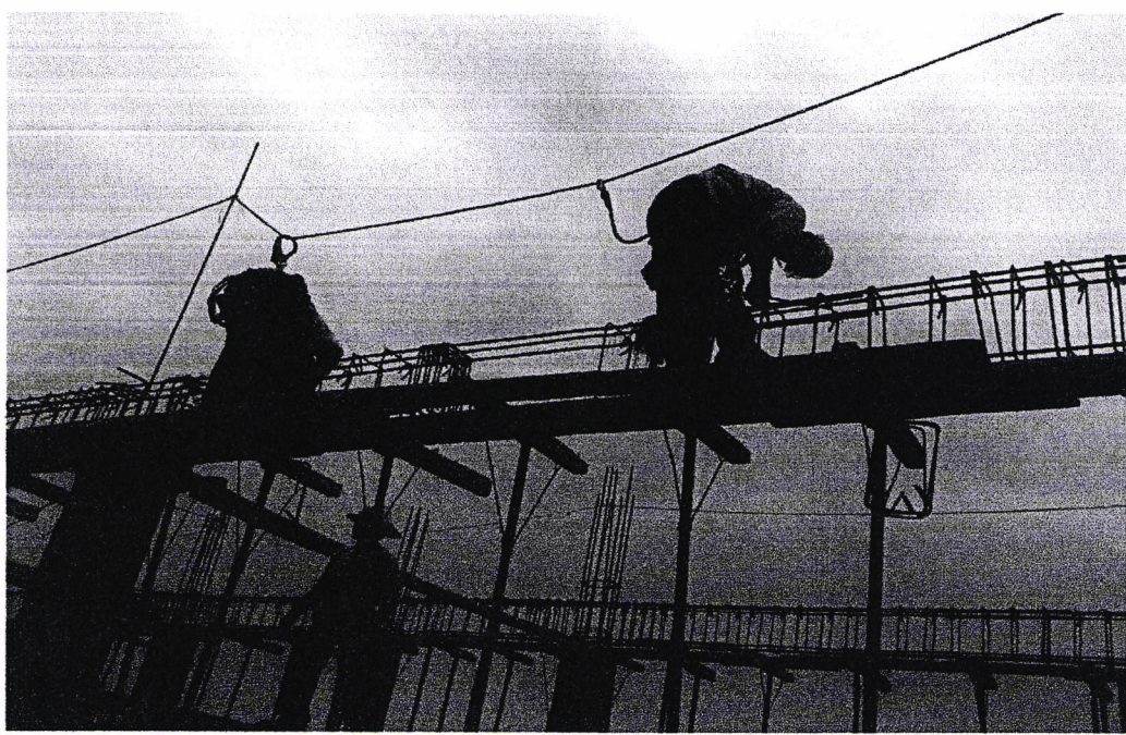
ACERO VIGAS BLOQUE PRINCIPAL
