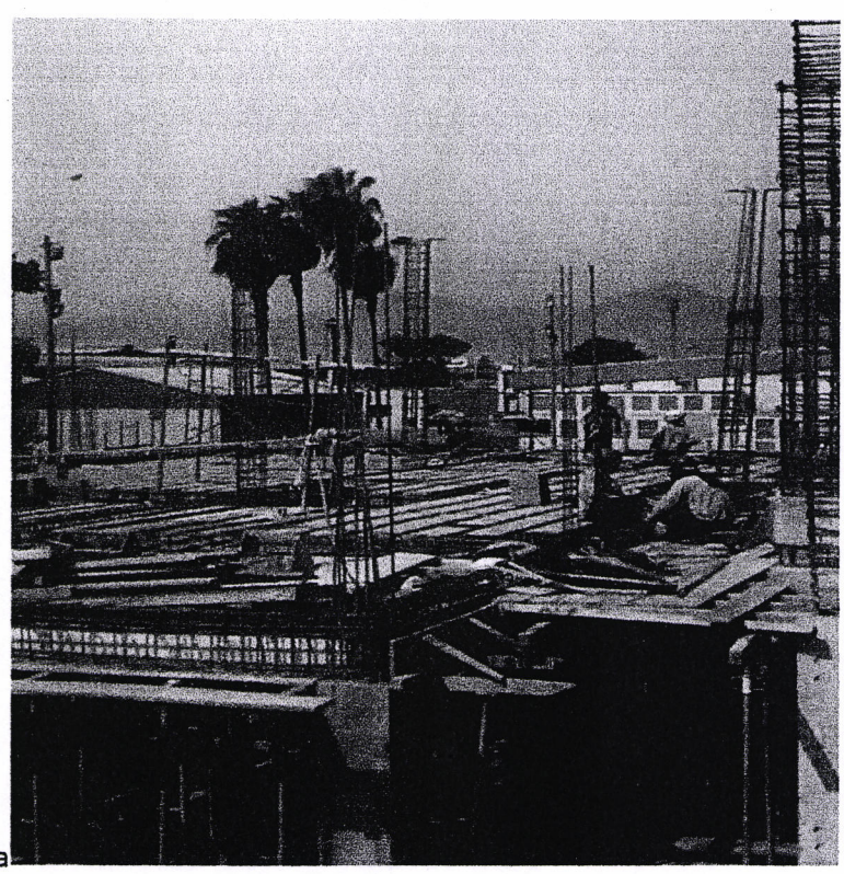
ENCOFRADO Y LADRILLO TECHO 1ER PISO BLOQUE PRINCIPAL EJES A - C
